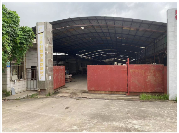
东南面消防器材厂
