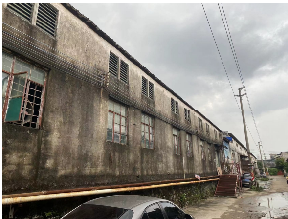
西北面工业厂房
