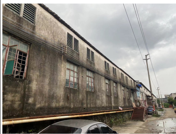
西北面工业厂房
