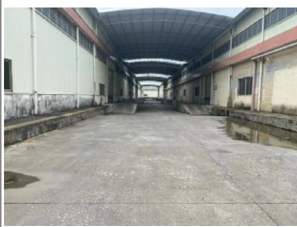
项目内现状厂房（待拆）
