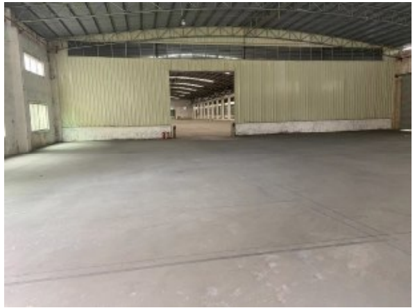
项目内现状厂房内
