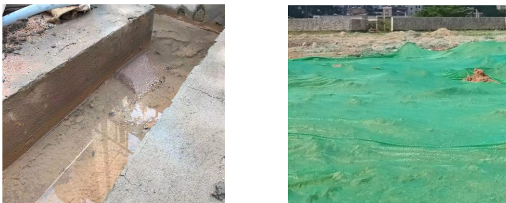
图4.3-1 水土保持临时措施
